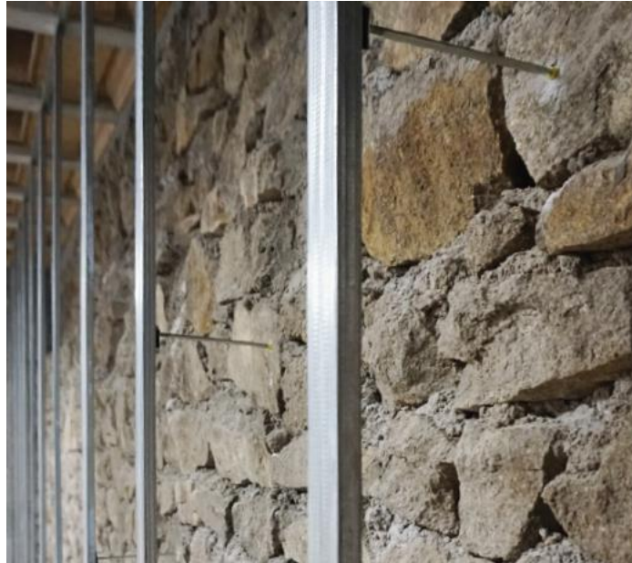
Figure 1 : Illustration du procédé FIX-FOURRURE
