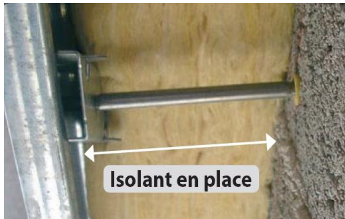
Figure 2 : Illustration du complexe {vis – cavalier – fourrure verticale clipsée}
