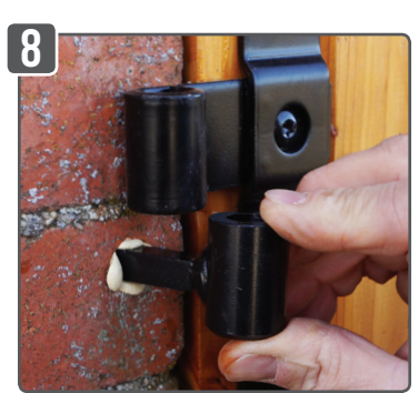
8 Mettre en place le gond immédiatement après avoir injecté la résine.
