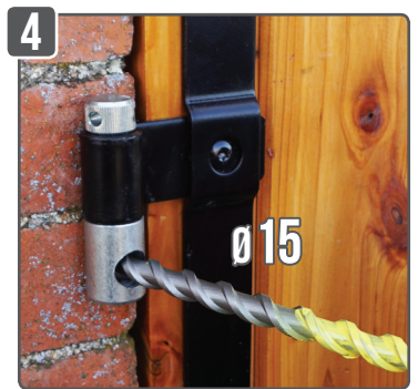
4 Percer avec une mèche Ø 15 mm, en respectant la profondeur de perçage grâce au repère jaune. Une bonne profondeur de perçage = gain de temps et économie de résine.
