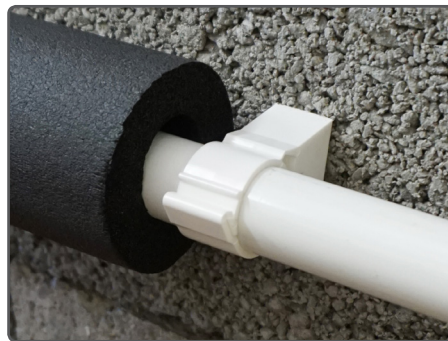
Bonne distance du mur pour le passage de l'isolant
