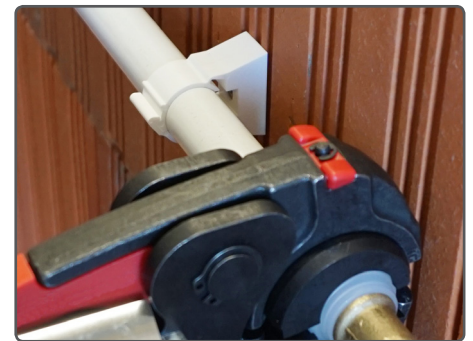
Utilisation de la pince à sertir sans démontage du tube
