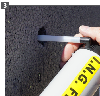
Nettoyez le trou à l'aide d'une pompe soufflante.
