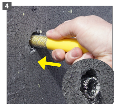
Insérez le filtre à l'aide de l'outil de pose.
