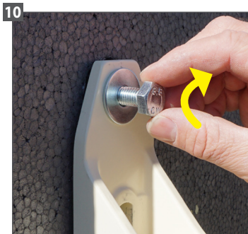
Vissez. La rondelle d'appui évite l'écrasement de l'isolant.
