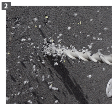
Percez Ø 20 mm à travers l'isolant.
