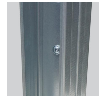
Vis ossature plaque de plâtre - montants dos à dos
