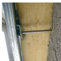
Fix-Fourrure - vue en situation avec isolant
