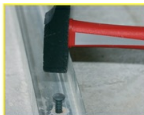
3- Enfoncer à l'aide d'un marteau
