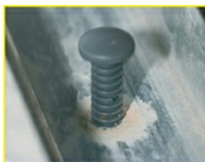
2- Positionner le Fix-Rail
