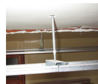
FIX-FOURRURE - vue en situation au plafond
