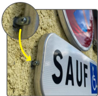
Fixation panneau signalétique - vue en situation
