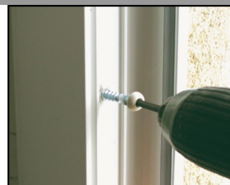
3. La VIS-TOP se visse et se dévisse pour un alignement parfait
