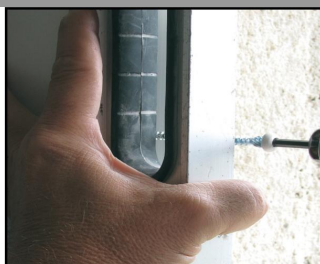
2. La main libre permet de pouvoir maintenir le niveau pour vérifier l'aplomb
