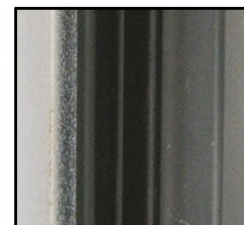
5. joint de finition mis en place.
