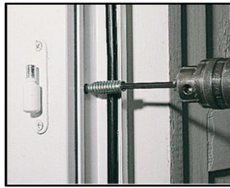
2. Enfoncer la vis TOP ROC jusqu'au filetage et visser.
