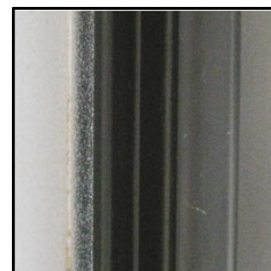
4. Joint de finition mis en place.
