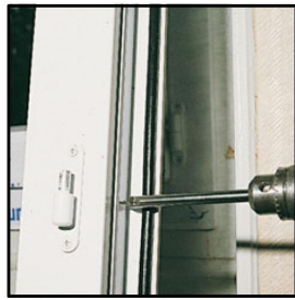
1. Percer la menuiserie Ø8 mm.
