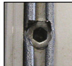
4. Vis Top-Roc mise en place.
