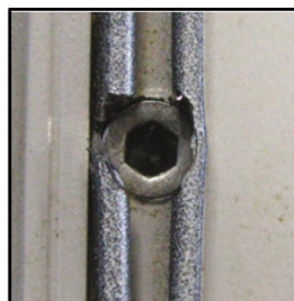
3. Vis Top-Roc mise en place.
