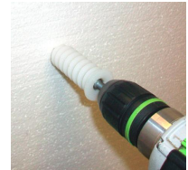
Cheville polystyrène - vue en situation
