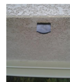
Battement haut ISO pour espagnolette - après isolation
