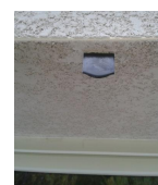
Battement haut ISO pour espagnolette - après isolation
