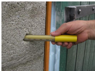
Filtre métallique - vue en situation
