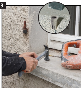
3 Enfoncer la cheville à l'aide d'un marteau.
