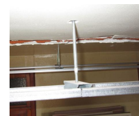
FIX-FOURRURE - vue en situation au plafond
