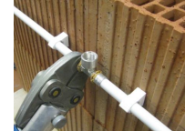
TUB-RING - vue en situation avec pince à sertir
