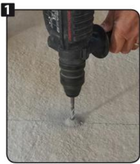
Drill Ø 8 mm (Ø16 à 20) Ø 10 mm (Ø 22 à 26).
