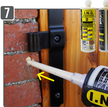
7 Seule notre clavette permet ce contrôle. Une fois effectué, injecter la résine en respectant la graduation.
