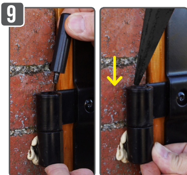
9 Insérer la clavette. Important : donner un seul coup de marteau en maintenant le corps de gond pour bloquer la clavette.
