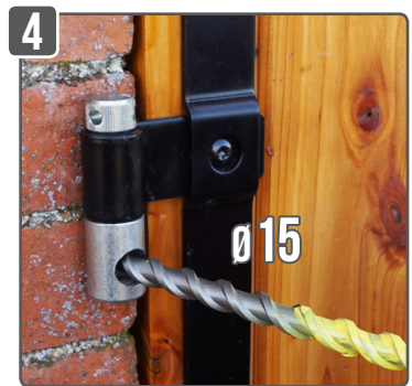
4 Percer avec une mèche \varnothing 15 mm, en respectant la profondeur de perçage grâce au repère jaune. Une bonne profondeur de perçage = gain de temps et économie de résine.
