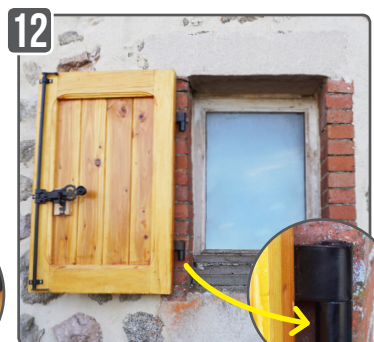
12 L'ouverture du volet est possible après vérification du durcissement de la résine.
