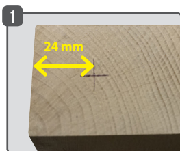
1 Repérer le trou sur le portail à 24 mm du bord.
