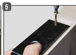
Fixer l'équerre sur le portail à l'aide de vis à bois.
