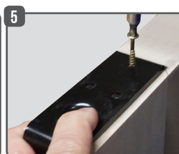
5 Fixer l'équerre sur le portail à l'aide de vis à bois.
