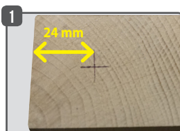
Repérer le trou sur le portail à 24 mm du bord.
