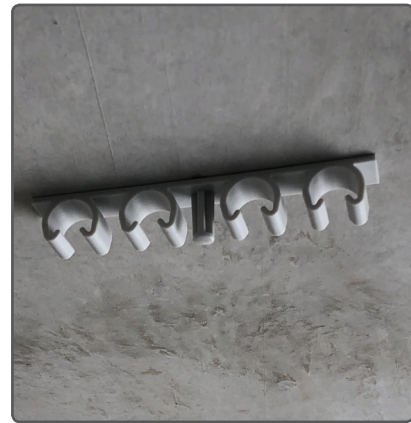
Le FIX-RING MULTI® quadruple est mis en place !
