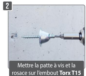
Mettre la patte à vis et la rosace sur l'embout **Torx T15**
