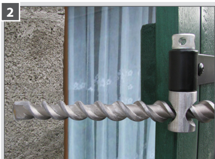
2 Percer au travers du gabarit de perçage.
