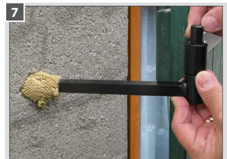
7 Mettre en place le gond et la clavette immédiatement après avoir injecté la résine.
