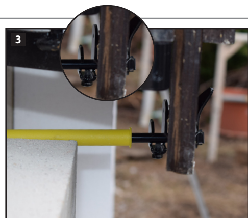
Installer la butée universelle : l'arrêt de volet ISO est mis en place !
