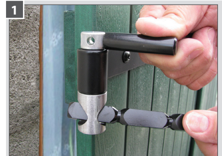
1 Mettre en place le gabarit de perçage et le serrer à l'aide de la clavette et de la queue du gond.
