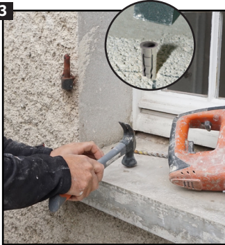
Enfoncer la cheville à l'aide d'un marteau.
