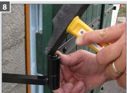
8 Pour bloquer la clavette autobloquante, donner un seul coup de marteau.
