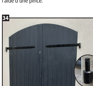
30 Serrer la tige filetée sur l'ancien gond à l'aide d'une pince.
