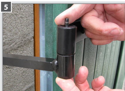
5 Pour contrôler si le perçage est correct : on peut mettre le gond et positionner la clavette à l'envers pour pouvoir la retirer.
