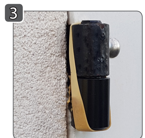
Installation du gond dans le bloc isolant
