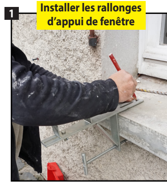
Positionner la rallonge sur l'appui de fenêtre et tracer un repère. Mallette : réf. A130112
