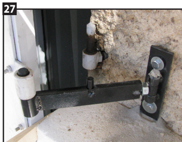
27 Le corps de gond est en place.
