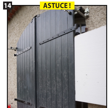
Placer une plaque d'isolant contre le volet pour contrôler le déport (tenir compte de la colle et de la finition).
