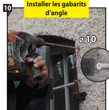
Percer Ø 10 et enfoncer la cheville blanche. Mallette : réf. A130110
