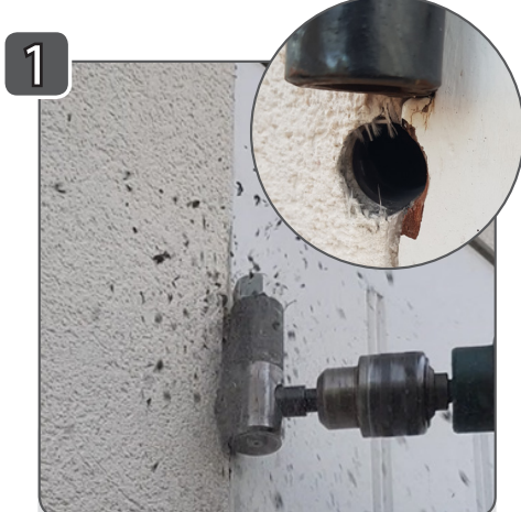
Perçage dans le bloc isolant 3 étapes
