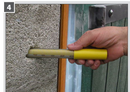
4 Mettre en place le filtre à l'aide de l'outil de pose.
