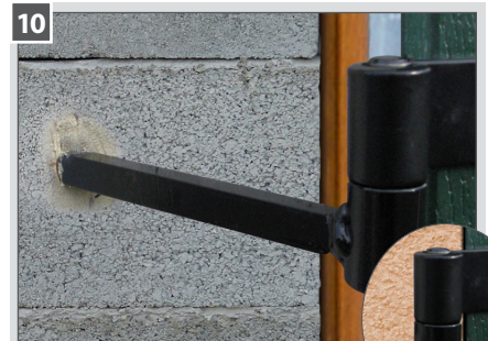
10 Le gond est en place.
